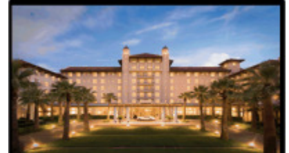
Hotel automation اتوماسیون هتل
