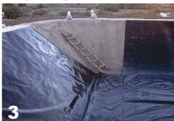
3 نمونه برش و قرا رگیری ورق در کنج
