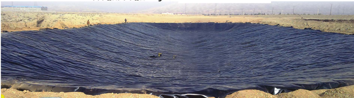
▲ دریاچه ذخیره آب کشاورزی ۵۰۰۰۰ مترمکعب مزرعه آقای فاضل سعیدی - پاکدشت
