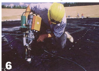
6 جوش دستی در مملهای تقاطع ورق
