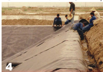
4 مهار ورق در ترانشه مفر شده
