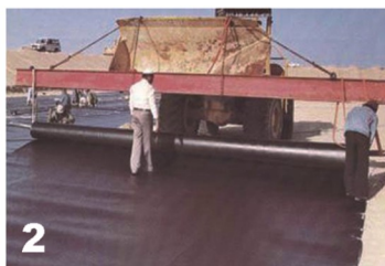
2 پهن کردن ورق ژئوممبرین بصورت دستی و ماشینی
