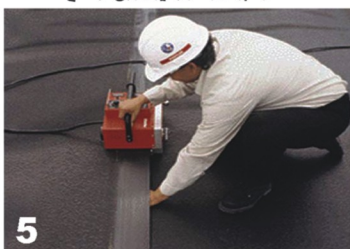
5 جوش ورق بوسیله دستگاه اتوماتیک
