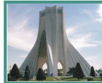
نام پروژه: بازسازی میدان آزادی کارفرما: شهرداری منطقه ۹ مجری: شرکت نبشینه بتن سال اجرا: ۱۳۸۶ کاربری: مصفاقت ژئوممبران در ایزولاسیون برج میزان مصالح بکار رفته: ۳۲۰۰۰ متر مربع
