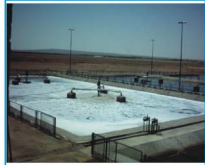
نام پروژه: تصفیه خانه فاضلاب شهر داران مجری: شرکت شکل سازه کارفرما: شرکت آب و فاضلاب استان اصفهان کاربری: مصفاقت از ژئوممبران در ایزولاسیون مخازن سال اجرا: ۱۳۸۶ میزان مصالح بکار رفته: ۲۰۰۰ متر مربع
