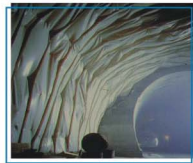
نام پروژه: ایستگاه ۷۲ متری تهران و مومه مجری: شرکت ترافیت کارفرما: شرکت مترو تهران و مومه سال اجرا: ۱۳۸۶ کاربری: مصفاقت از ژئوممبران در ایزولاسیون تونل میزان مصالح بکار رفته: ۱۵۰۰ متر مربع
