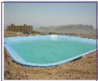
نام پروژه: احداث استخر مجری: شرکت آسفامبر کارفرما: شرکت تاشا ماشین سال اجرا: ۱۳۸۶ کاربری: مصفاقت از ژئوممبران در ایزولاسیون استخر میزان مصالح بکار رفته: ۲۰۰۰ متر مربع
