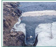
نام پروژه: سافتمان گلد ایران کارفرما: شرکت LG مجری: انجمن ژئوتکنیک سال اجرا: ۱۳۸۶ کاربری: زهکشی میزان مصالح بکار رفته: ۲۰۰۰ متر مربع
