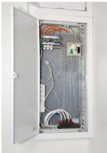
شکل ۶-۱۶: OTO ادغام شده در اتاقک توزیع خانه
