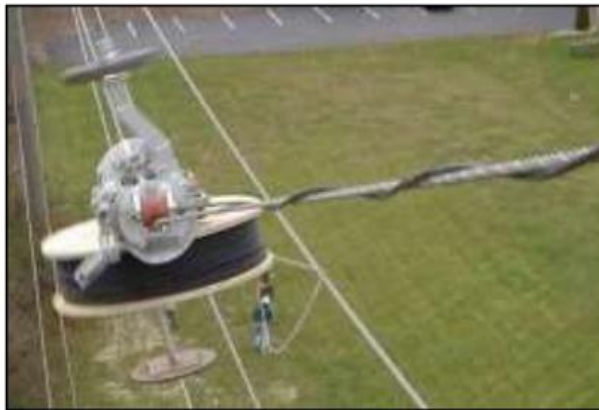
شکل ۷-۲۹: کابل هوایی پیچیده شده
