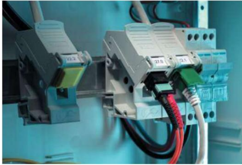
شکل ۶-۱۷: OTO ادغام شده در پنل توزیع برق خانه
