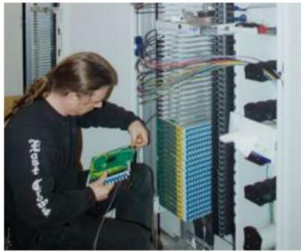
شکل ۸-۲: کار جداسازی در یک ODF
