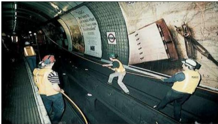
شکل ۷-۴۰: نصب کابل در یک تونل مترو
