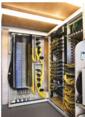
شکل ۳-۵: نمای یک POP مجهز به یک ODR، سوئیچ های اتنرت، کنترل آب و هوا و UPS.
