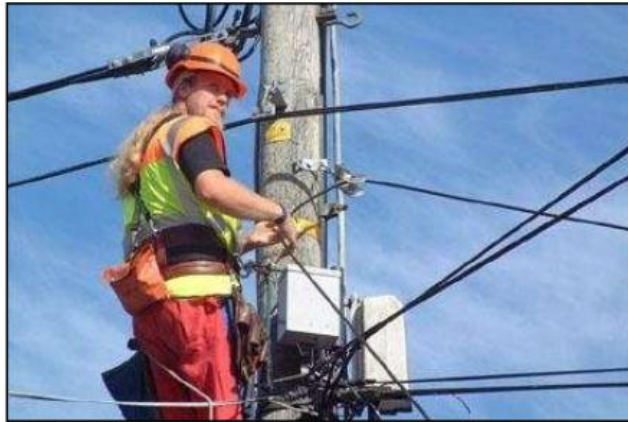
شکل ۷-۳۱: نصب کابل هوایی
