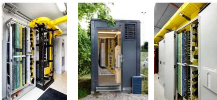
شکل ۸-۳: نمونه واحدهای ODF شکل ۱۱۳: POP کوچک شکل ۱۱۲: ODF فعال و غیر فعال در POP
