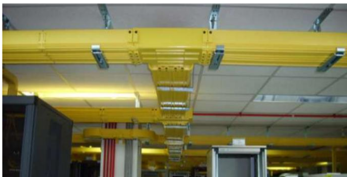
شکل ۸-۴: نمونه مهار فیبر بالای سر
