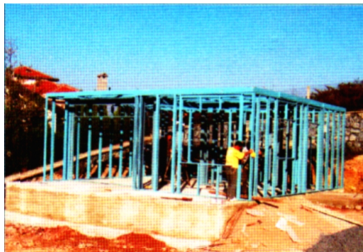
شکل ۸ . مراحل ساخت یک ساختمان به شیوه LSF
