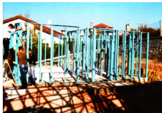
ادامه شکل ۸ . مراحل ساخت یک ساختمان به شیوه LSF
