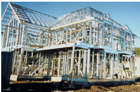
شکل ۱. اسکلت LSF یک ساختمان در کانادا
