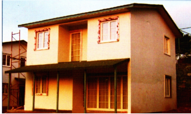
ادامه شکل ۸ . مراحل ساخت یک ساختمان به شیوه LSF
