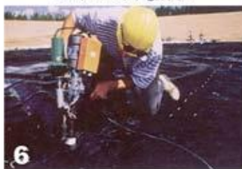
چوش دستی در مملهای تقاطع ورق
