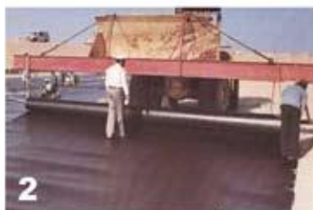
پهن کردن ورق ژئوممبرین بصورت دستی و ماشینی
