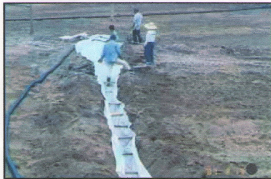
قرار دادن لوله تفلیه در کف استخر
