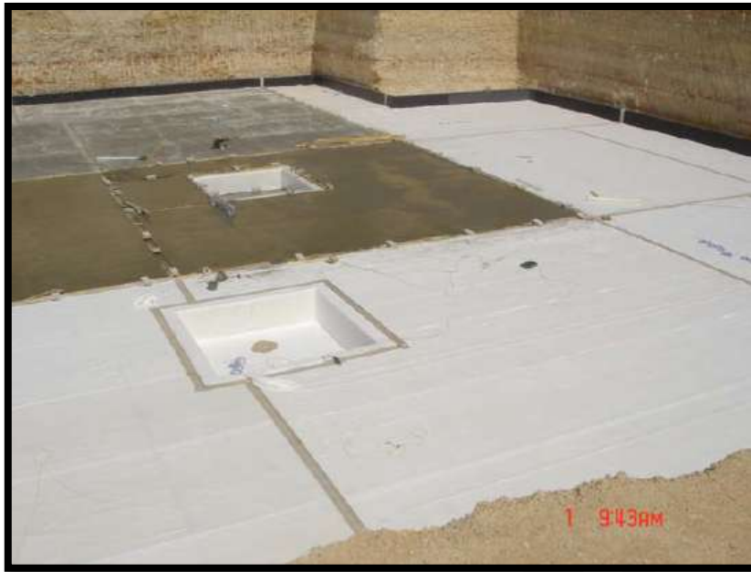
شکل) اجرای بتن محافظ
