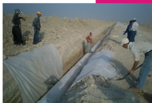
جلوگیری از شناور شدن لوله مفاظت از فطوط لوله
