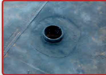
▲ آب بندی لوله ها
