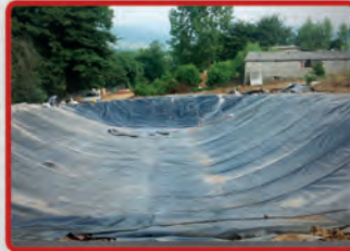
▲ استخر ذخیره آب قائم شهر متراژ ۱۰۰۰ متر مربع
