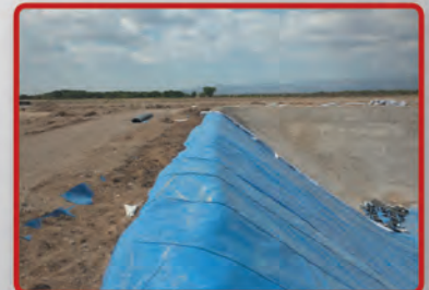
▲ پر کردن ترانشه ها
