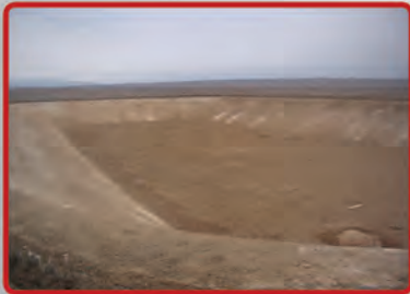
▲ بستر نهایی آماده نصب ژئوممبران
