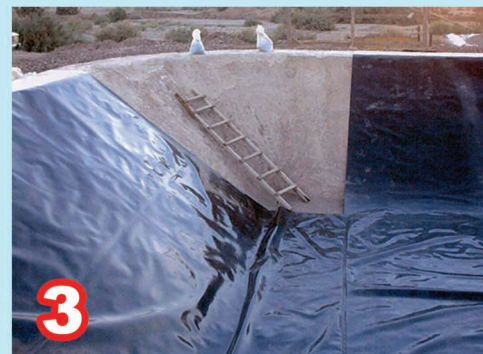
نمونه برش و قرارگیری ورق درکنج
