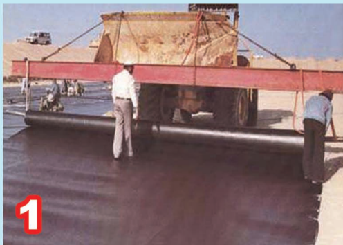
پهن کردن ورق بصورت دستی و ماشینی
