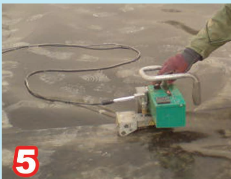
جوش ورق بوسیله دستگاه های دیجیتال
