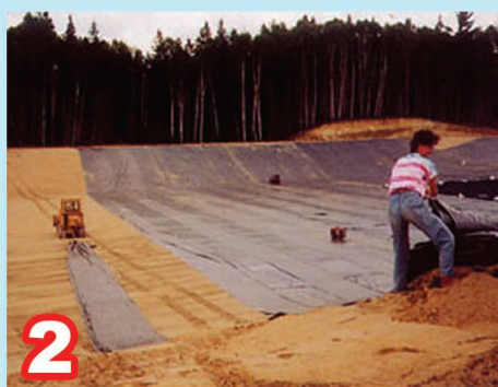
پیدمان ورق جهت جوش و نصب ورق
