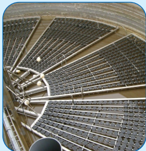
دیفیوزرهای دوار ولوله ای هواده های شناور و مستغرق
