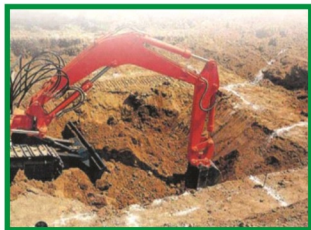
گود برداری بعد از تراز کردن سطح و کف استخر
