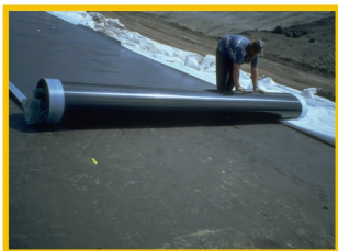
چیدمان ورق جهت جوش و نصب ورق
