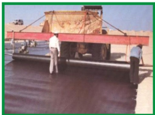
پهن کردن ورق به صورت دستی و ماشینی
