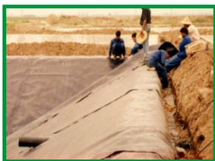
مهار ورق در ترانشه مفر شده
