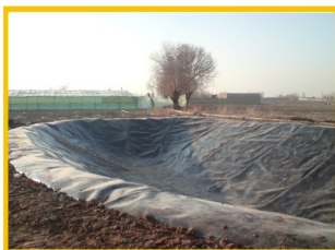
استخر آماده بهره برداری
