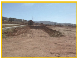
بستر گود برداری شده قبل از دادن تراکم به دیواره ها و کف
