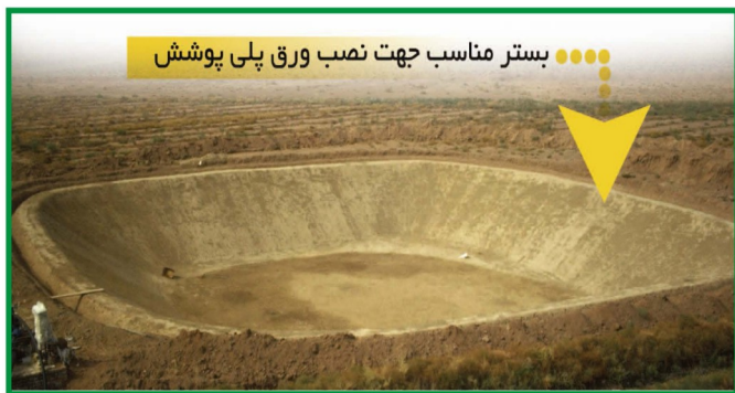
بستر آماده جهت نصب ورق پلی شیت
