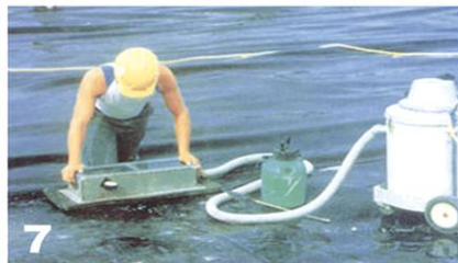
7 تست جوش دستی با دستگاه وکیوم
