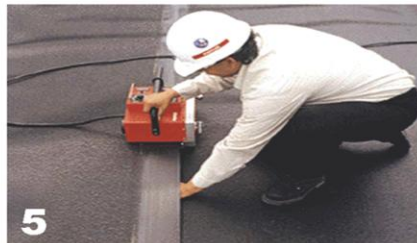
5 جوش ورق بوسیله دستگاه اتوماتیک
