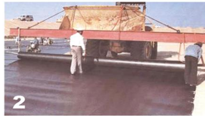
2 پهن کردن ورق ژئوممبرین بصورت دستی و ماشینی
