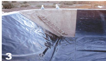
3 نمونه برش و قرا رگیری ورق در کنج
