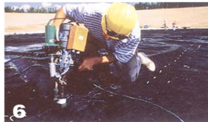
6 جوش دستی در مملهای تقاطع ورق
