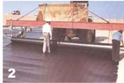
2 پهن کردن ورق ژئوممبرین بصورت دستی و ماشینی
