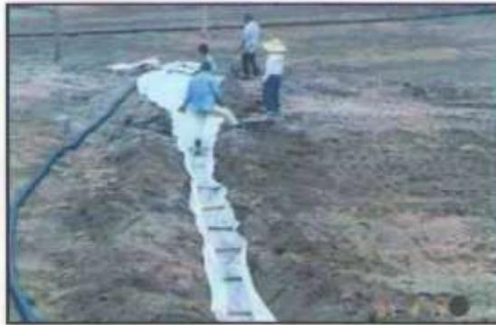
قرار دادن لوله تخلیه در کف استخر
