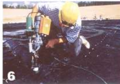
6 جوش دستی در محل های تقاطع ورق
