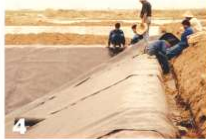
4 مهار ورق در ترانشه مفر شده
