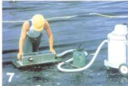
7 تست جوش دستی با دستگاه وکیوم
