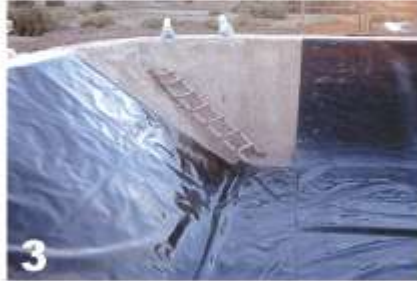
3 نمونه بردن و قرارگیری ورق در گنج
