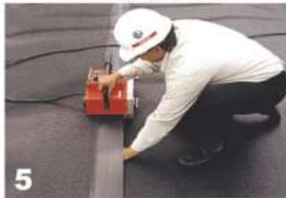
5 جوش ورق بوسیله دستگاه اتوماتیک
