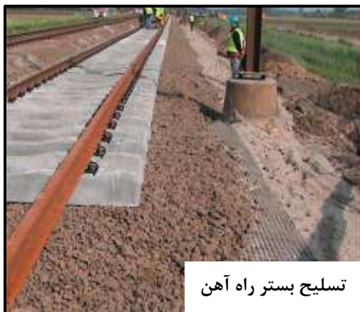
موقعیت قرارگیری ژئوگرید در بستر راه آهن
